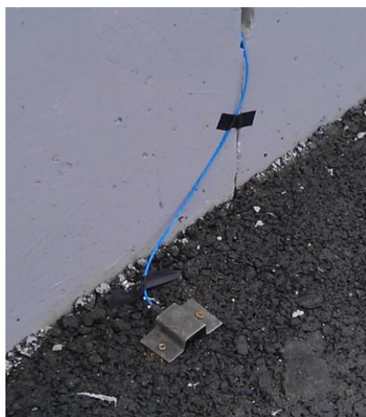
Fig. 6 Detaliu montaj traductorilor pentru preluarea accelerațiilor
