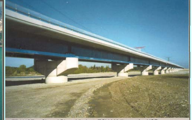
• FRANCE -- Cheval Blanc Viaduct, TGV Méditerranée, HSR pot bearings
