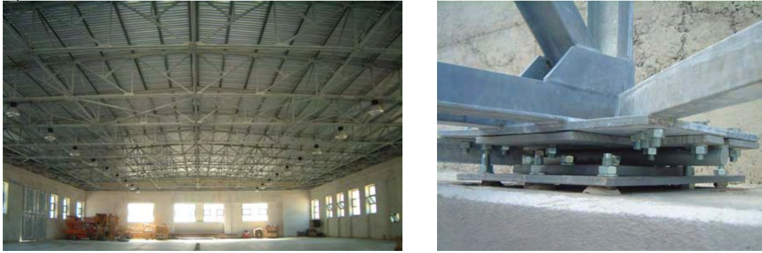
Fig. 2.2.2.1.2 Hala industrială în Sarno (Salerno, Italia) cu un caz particular de dispozitiv histeretic (8)
