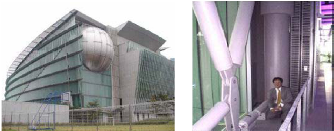
Fig. 2.2.3.2.3 Clădirea Nihon-Kagaku-Miraikan, Tokyo (Muzeul Național al Științei și Inovației) (26)
