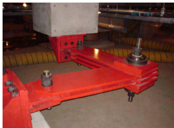
Fig. 2.2.2.2.7 Clădire cu 5 etaje, Japonia (Amortizor Damptech folosit la izolarea bazei) (10)
