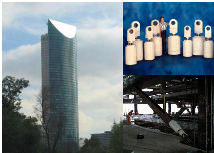
Fig. 2.2.3.1.4 Torre Mayor Building, Mexico City, SUA (mega-amortizori vâscoși in cadrul sistemelor de contravântuiri excentrice) (18) (19)
