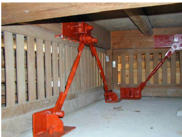
Fig. 2.2.2.2.6 Templul Yaguriji, Japonia (Amortizori cu frecare tip Damptech) (10)
